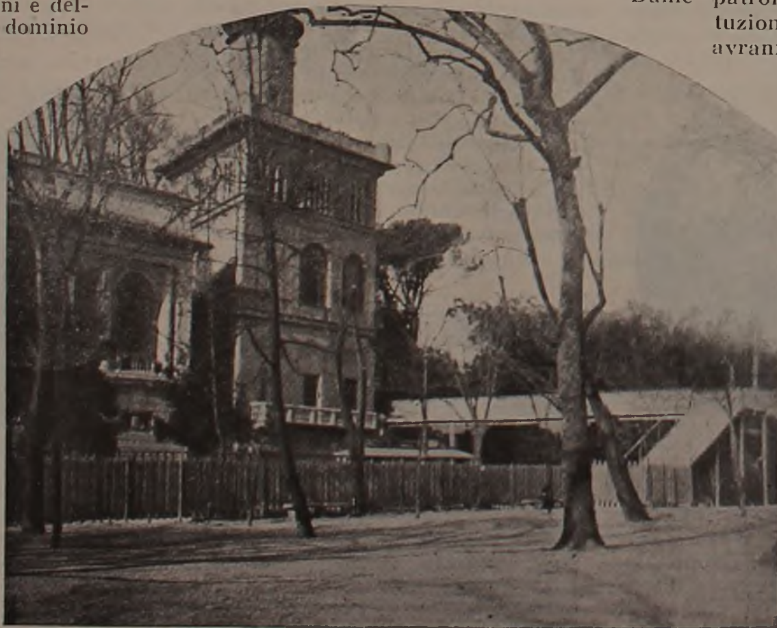
La villetta Serra e il ponte di comunicazione con l'Acquasola.
