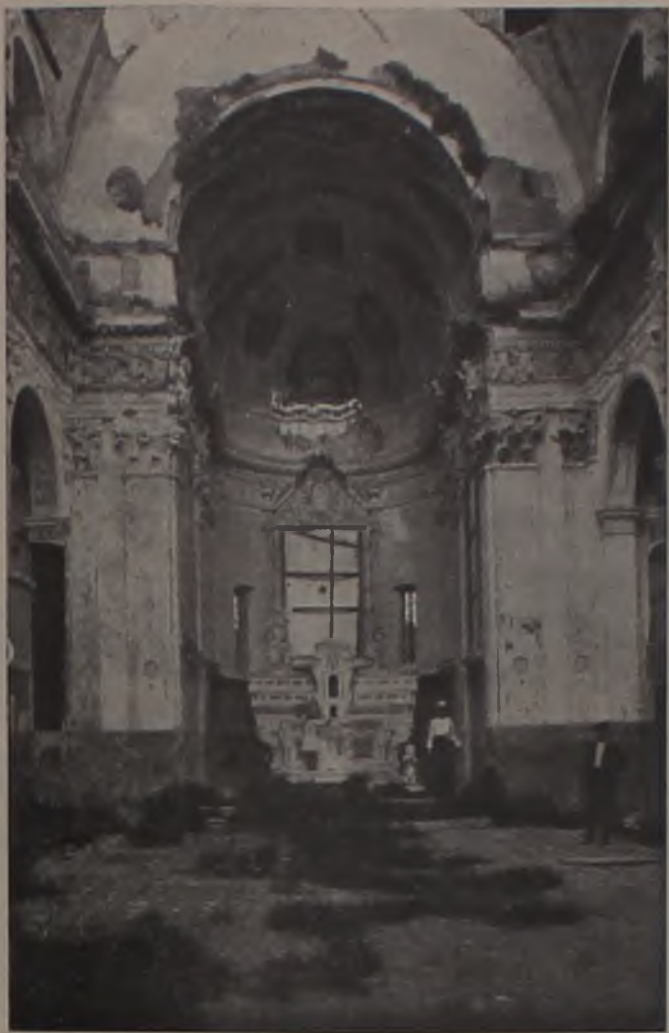
Interno della Chiesa di Bussana.
