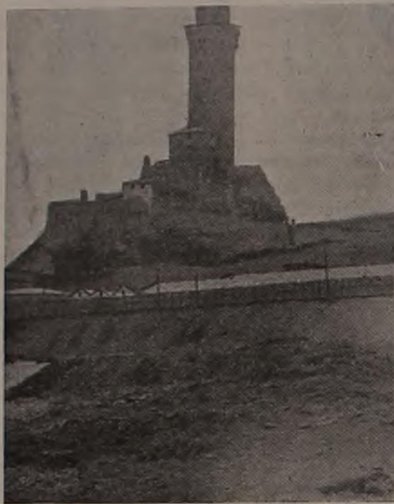
I lavori sotto la Lanterna.
