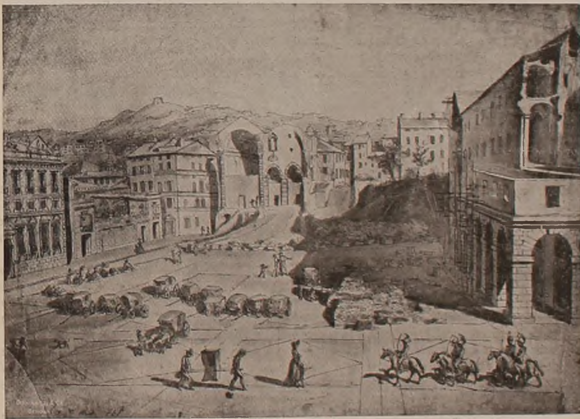
Demolizione della Chiesa di San Domenico per la costruzione del teatro acquarello del celebre pittore Francesco Baratta eseguito nel 1824
