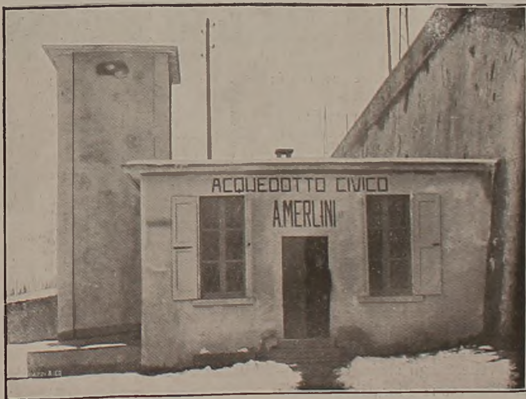
Centrale elettrica di presa d'acqua e cabina di trasformazione dell' energia elettrica
