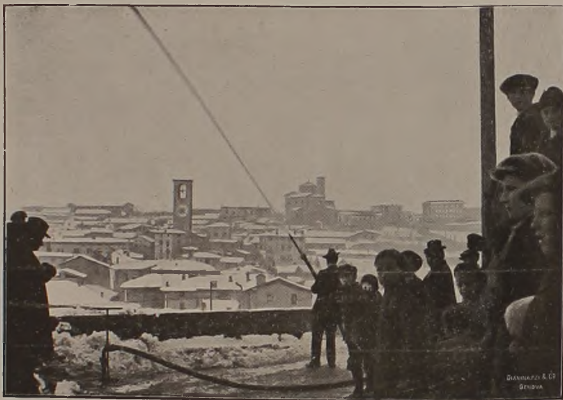
Idrante da incendio in funzione nella città alta; in fondo al panorama, vedesi la torre serbatoio.
