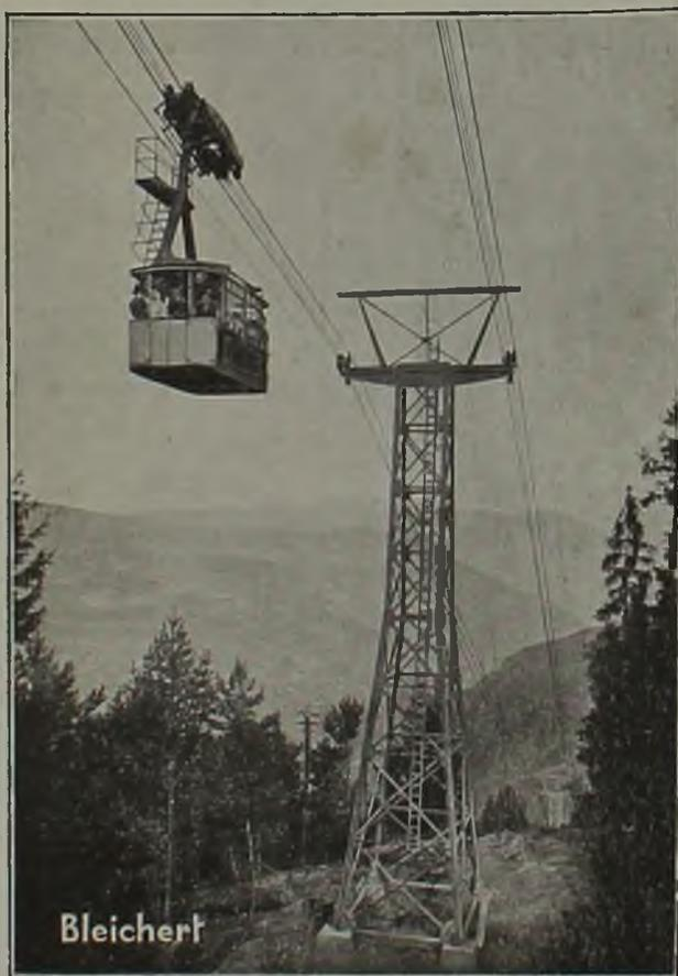
Vista della vettura e di una torre per l'appoggio delle funi
