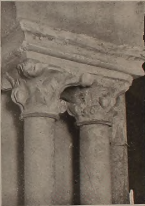
PARTICOLARE DEL CHIOSTRO.
