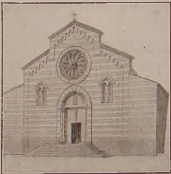
Chiesa di S. Andrea con finestre bifore restaurate e progettato rosonone centrale su disegno del Comm. d'Andrade
