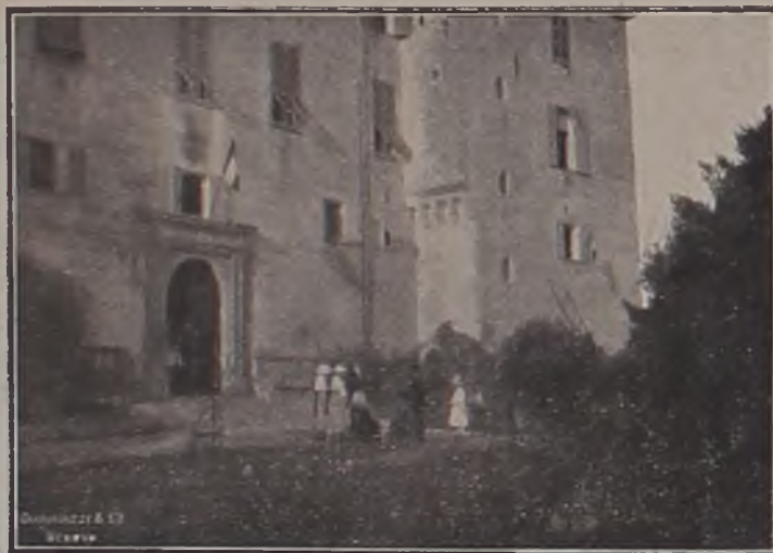
Ingresso al Castello di Tassarolo.
