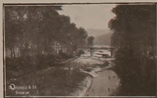
Il Maremola e il ponte della strada-ferrata
