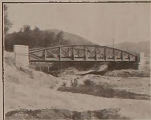
Ponte nuovo sul Maremola
