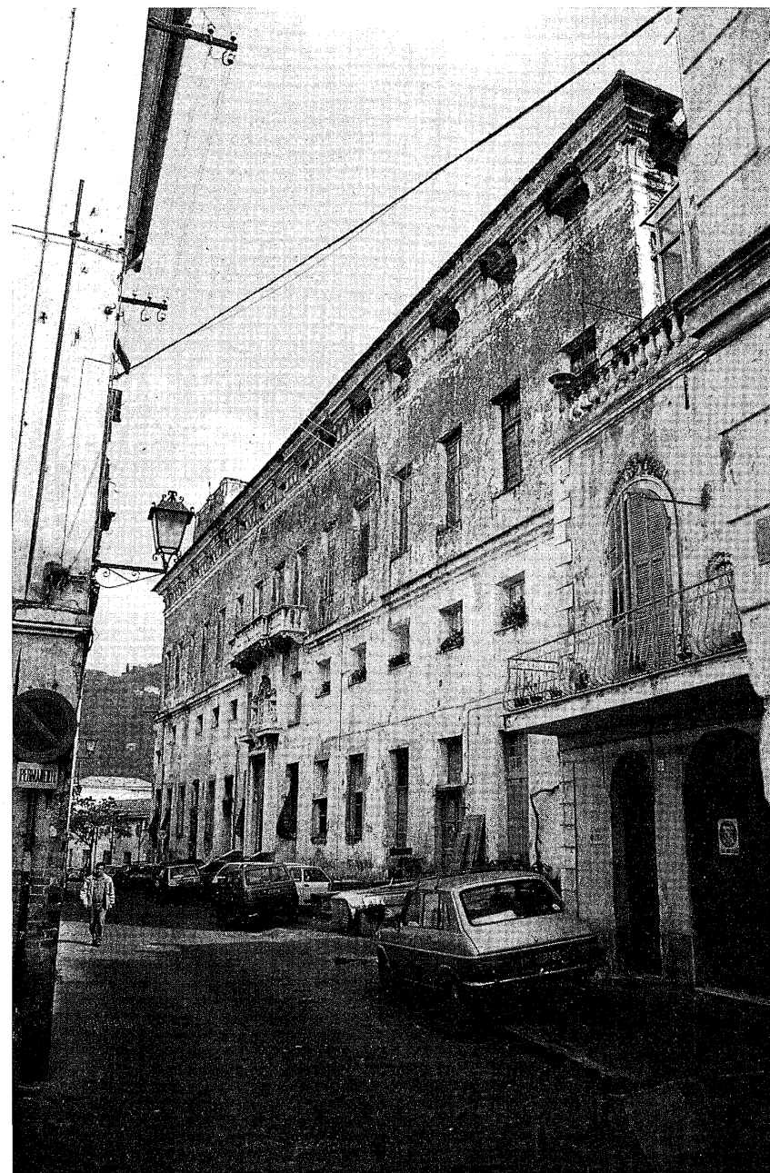
Taggia, palazzo Curlo. Facciata da Nord-Ovest.
