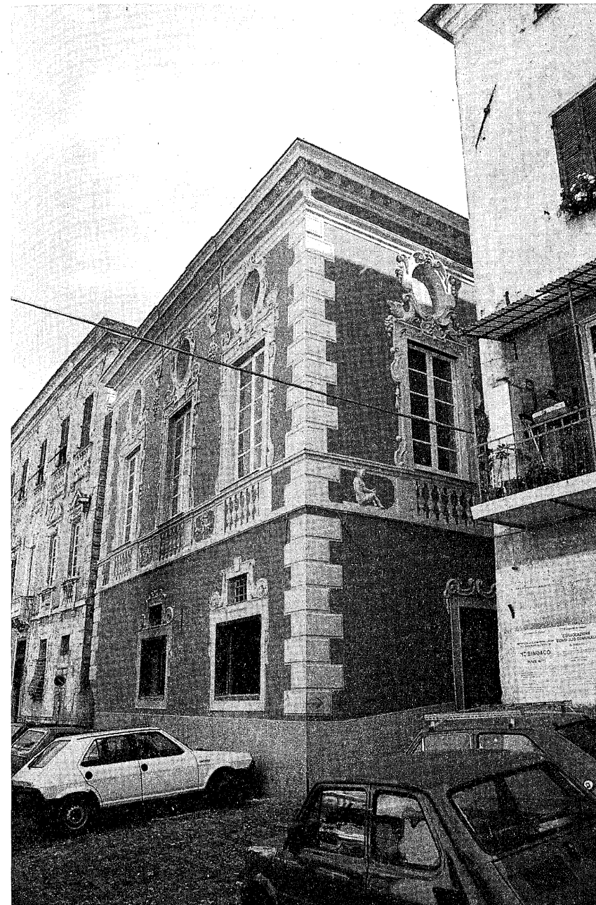
Taggia, Palazzo Lercari. Prospetto da Nord-Ovest.
